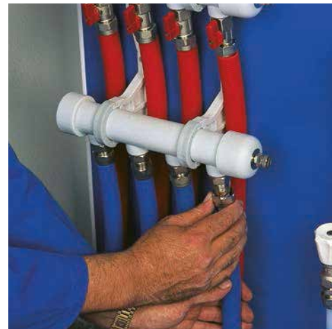
6- Kesilen uç kolektör bağlantı seti ile kolektöre bağlanır.
