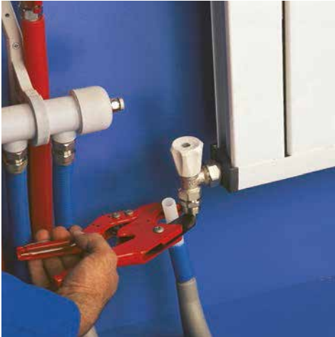
3- Boru radyatör bağlantı nipelini hizasından kesilir.
