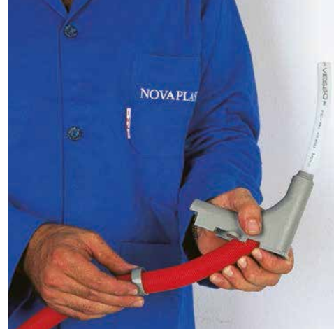
2- Kesilen boru köşe düzeltici ayak içinden geçirilir.
