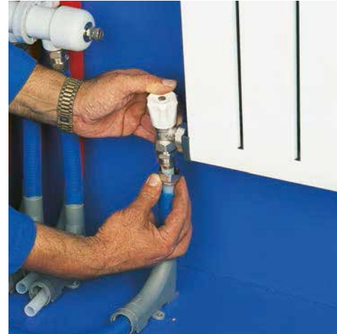
4- Radyatör bağlantı seti ile radyatöre bağlanır.
