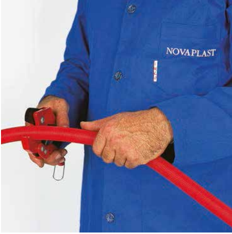
1- Boru özel makası ile dik olarak kesilir.
