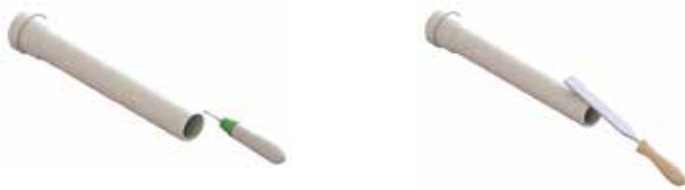
Şekil 13. VESBO INCOLA SBS Boru Uç Kısımlarının Temizlenmesi
